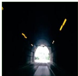
无灯光隧道或灯光分布不均、阳光斜射情况
