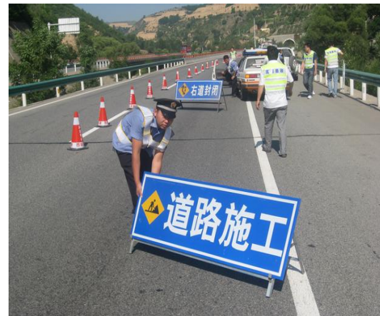
施工路段管制设置的统一
